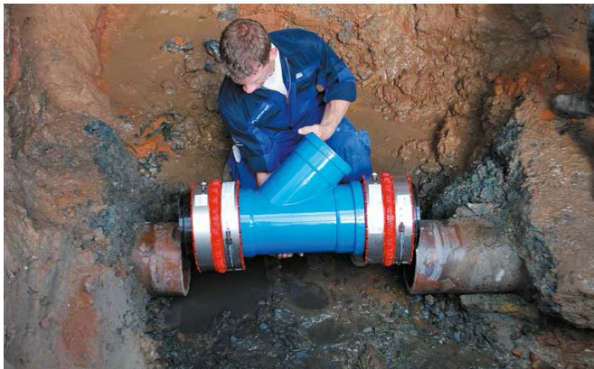
Raccordement de canalisation de branchement sur la canalisation.
