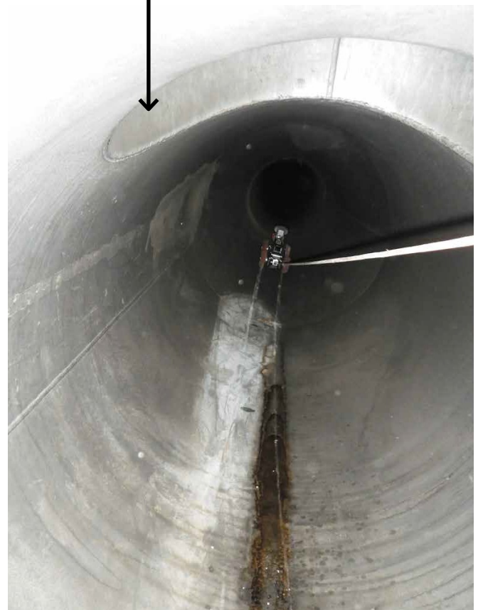
Passage d'une caméra dans un collecteur d'assainissement.
