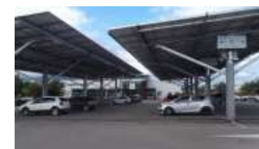
Illustration 91 : Ombrières sur le parking de Casino à Latour-Bas-Elne (Source : L'indépendant)
