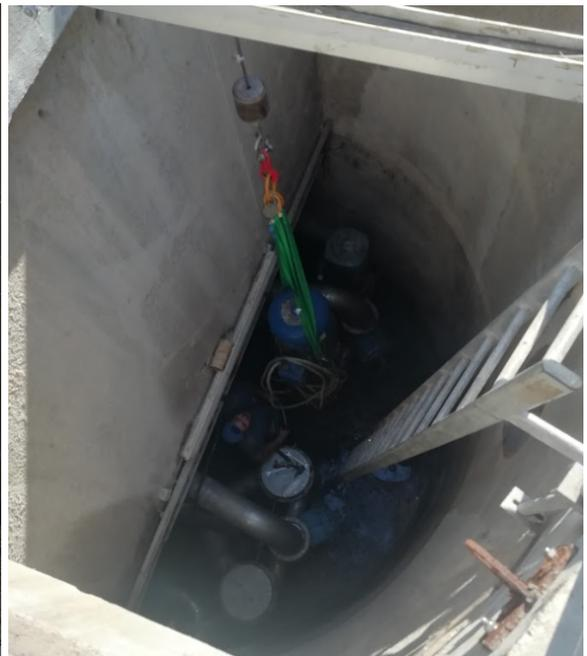
Décembre 2023 : Renouvellement complet de la nourrice du DIP avec mise en place d'un débitmètre de refoulement, d'une vanne d'isolement DN 400 et d'un piquage pour raccorder une pompe de secours.
