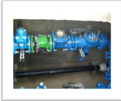
Afin de protéger le réseau de la ville, des éventuels retours d'eau contaminée en provenance de la station d'épuration, le réseau d'eau potable de l'usine est muni d'un équipement contre ces retours d'eau appelé « disconnecteur ».
