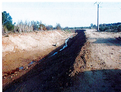
Secteur amont après travaux
