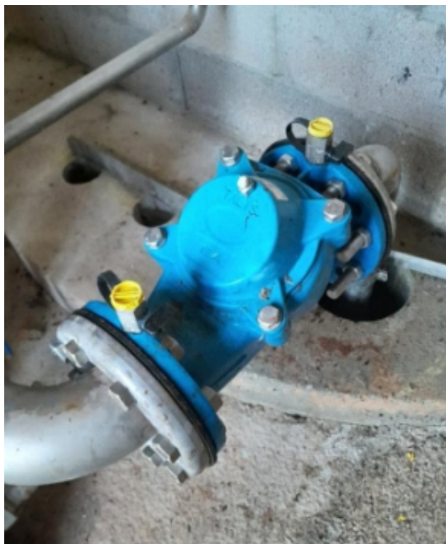
Renouvellement clapet aspiration STEP Corneilla
