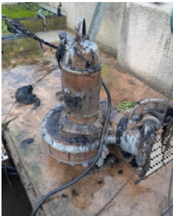
Pompe recirculation n°4 avant renouvellement STEP St Cyprien
